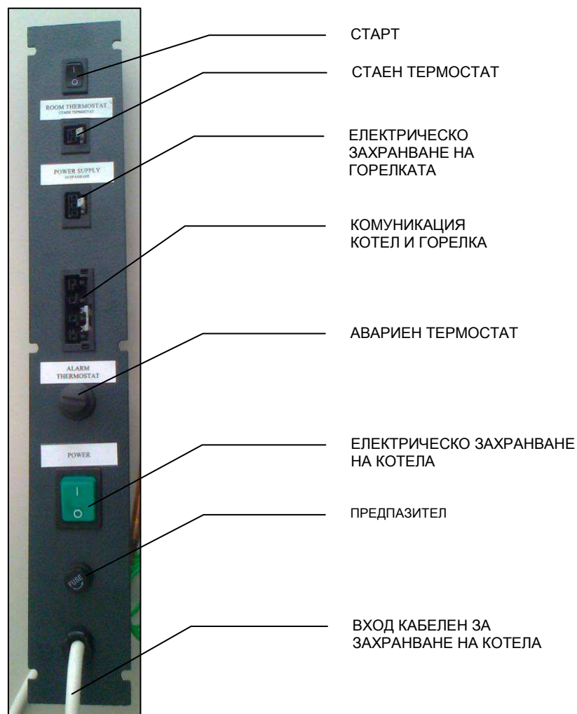
Фигура 11. Електрическо табло за управление на котела
